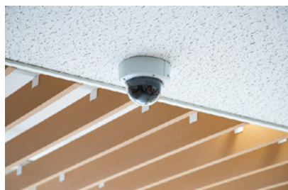
◀ 病院の入口天井に設置されたカメラ。これで患者様の顔情報を検知する
